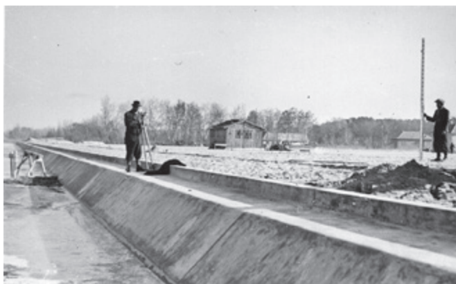
Partvédmű építése Balatonfenyvesen
