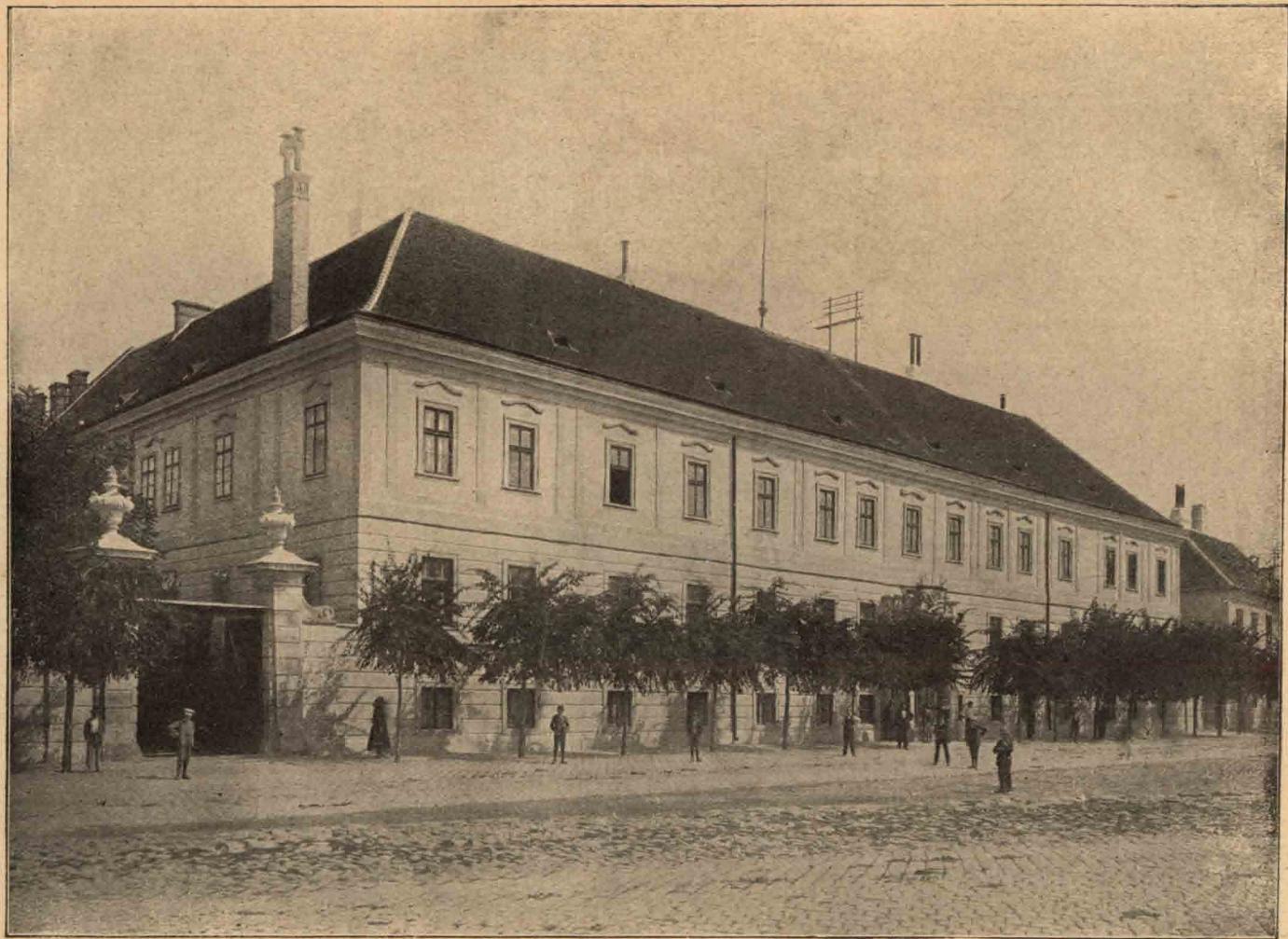
Az intézet régi épületének homlokzata.
