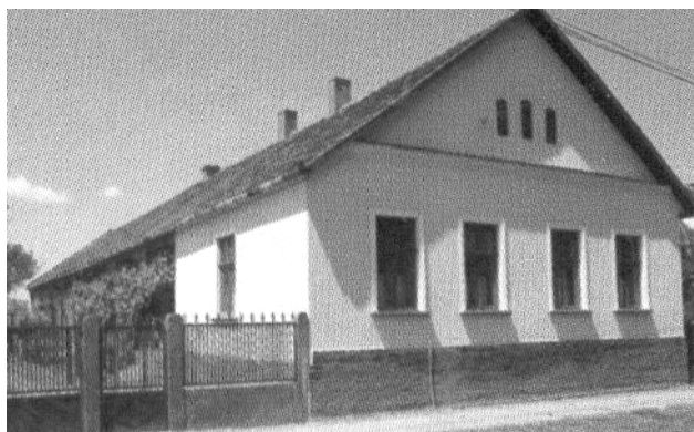
Felújított, módos sváb ház Vállajon
