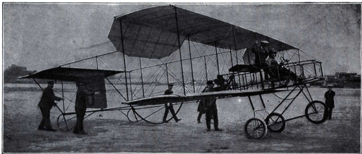
132. rajz. A legújabb Voisin-féle biplán. Bielovucie repülőgépes vezetésével. A mélységi és irányító kormányt a hátsó kamrában helyezték el, nincs rekeszték, helyette szárnyacsókák gondoskodnak az oldalbillenés egyensúlyozásáról.
