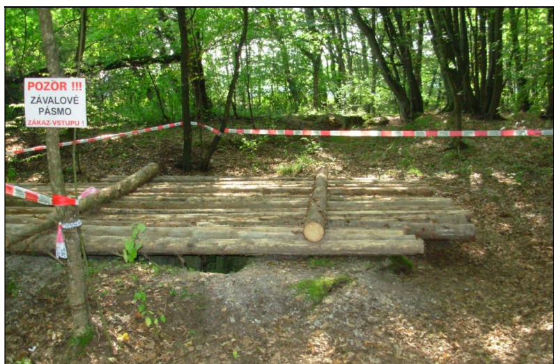
A gömbfával befedett függőakna.
