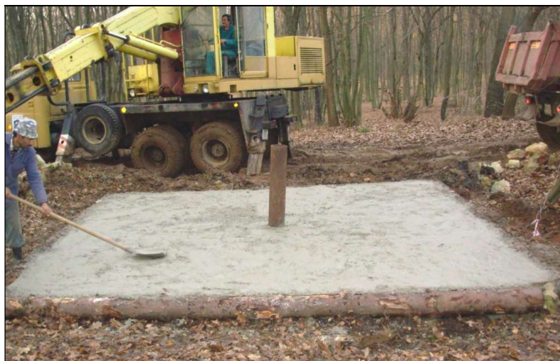
A nyílás bebetonozása.
