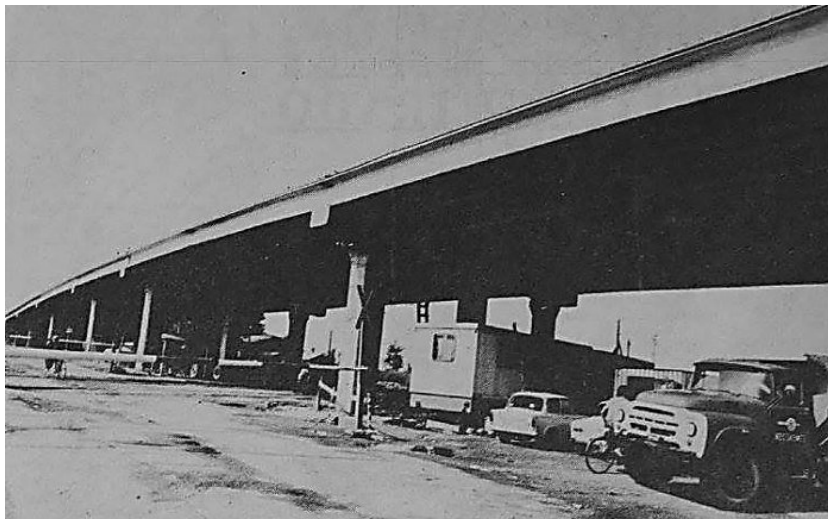
Épül a Halasi úti felüljáró 1981
