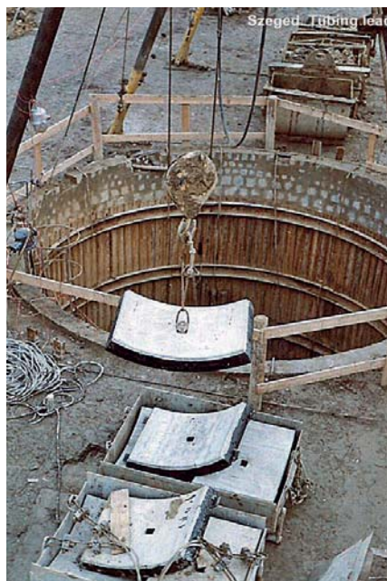
Tübingleadás pajzsos alagút építésénél.
