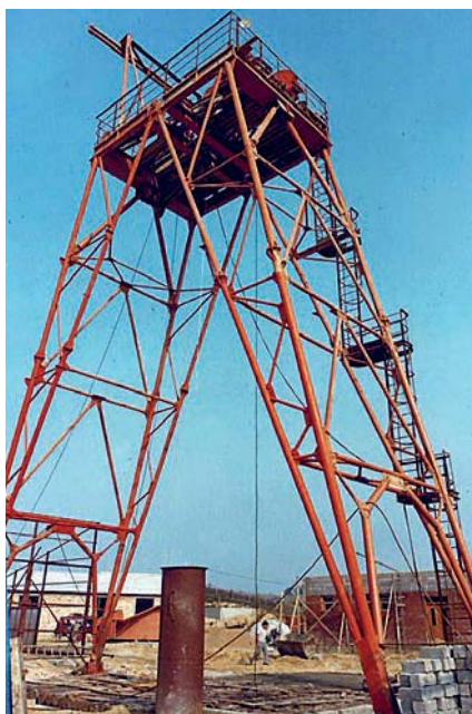
Duplex csőtorony aknamélyítésnél.
