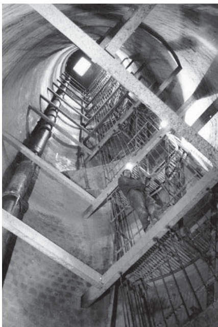
Függőleges akna szerelvényezése.
