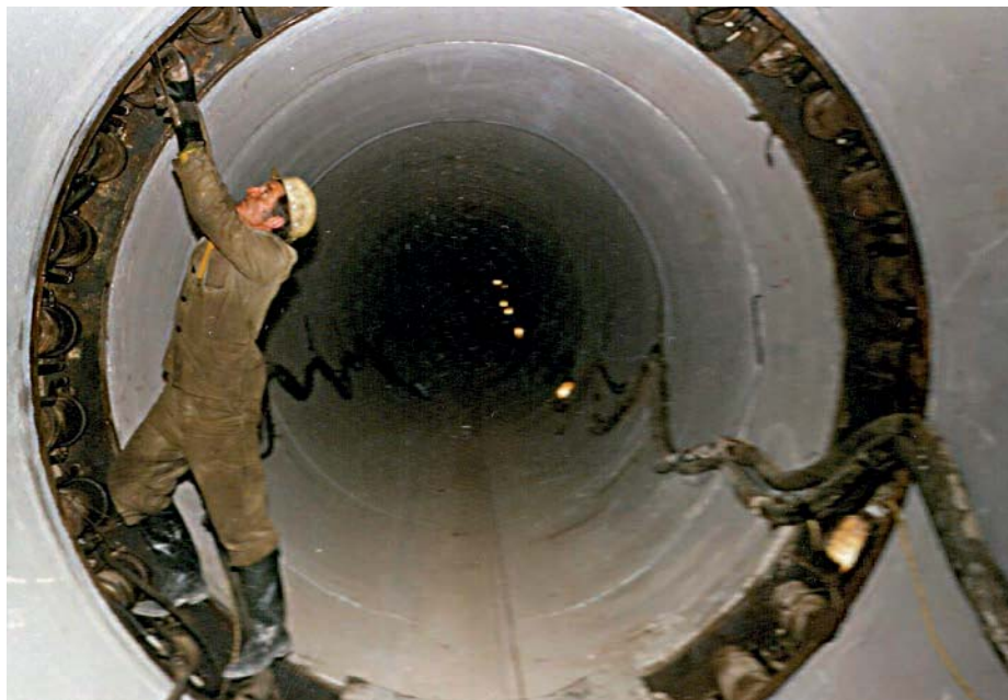
Vasbeton csőszajtolás közbeni állomása.
