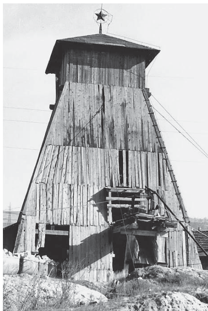
Faszerkezetű aknamélyítő torony.
