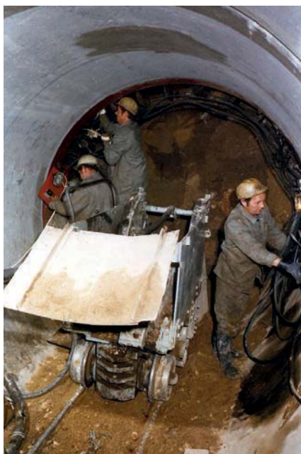
Vágóél-beállítás csőszajtolásnál.
