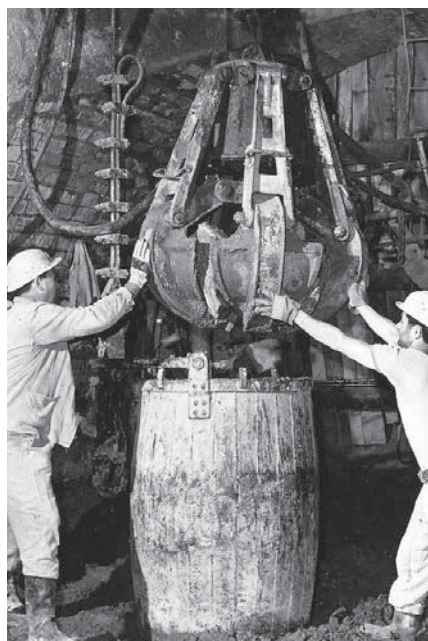
Rakodás aknamélyítésnél.
