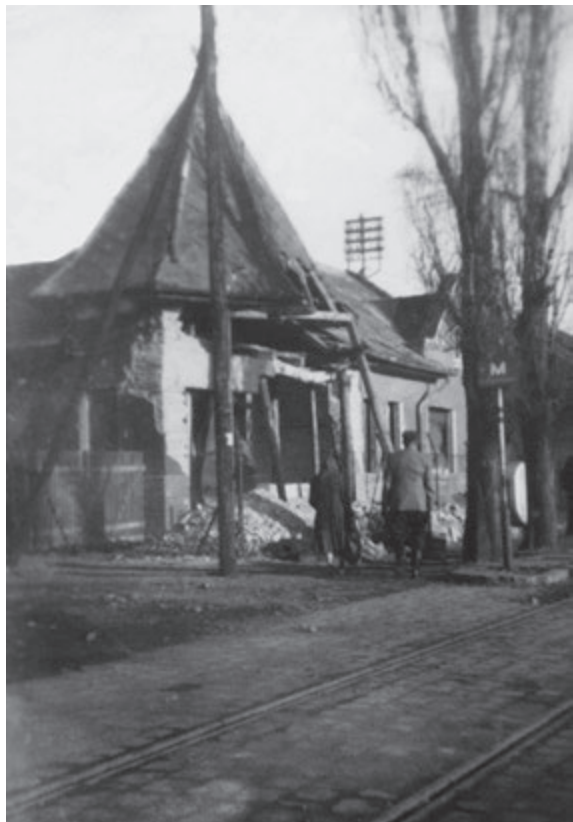
Sérült lakóház a Béke tér és az iparvasúti átjáró között
