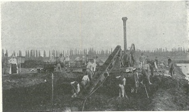
Fig. 111. Maschine zur Aufarbeitung des Torfes im Torflager Nagyberek bei Kéthely, Kom. Sopron.
