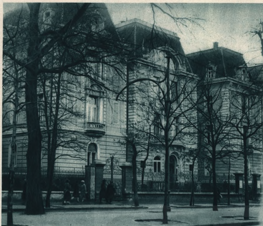
Fővárosi Fásor Szanatórium épülete
