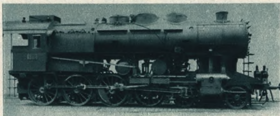
Máv. legújabb, 424. sorozatú túlhevítős mozdonya, készült a budapesti m. kir. állami gépgyárban.
