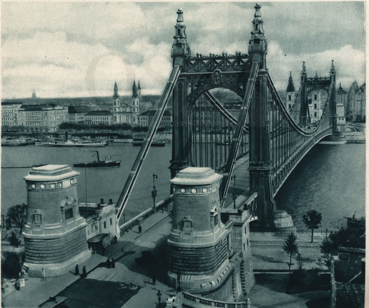
? — Die Elisabeth-Brücke, die grösste Kettensbrücke Europas mit einer einzigen Bogenspannung in der Länge von 290 m. — Le pont Elisabeth, le plus long pont suspendu à une arche dont la longueur est 290 m. — Az Erzsébet híd. Európa legnagyobb egynyílású Lánchídja, 290 m. hosszú nyílással fveli át a Dunát.
