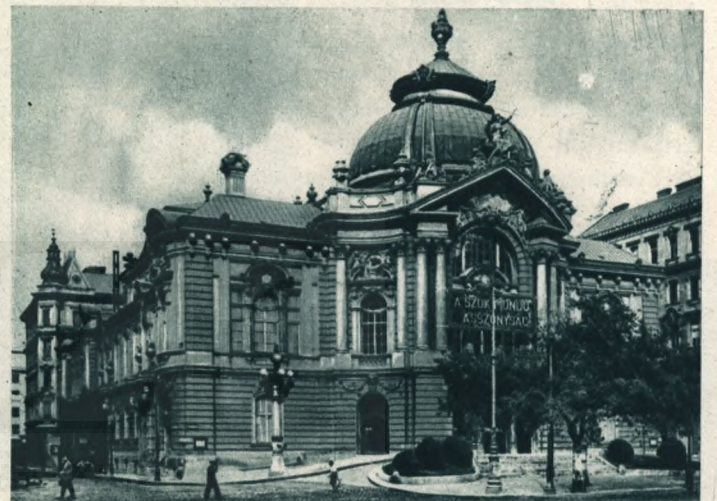
Galeté Theatre. — Lustspieltheater. — Théâtre de la Galeté. — Vigaszínház. There are in Budapest twelve similar theatres. — Elf solche Theater gibt es in Budapest. — Il y a douze théâtres pareils à Budapest. — Tizenegy ilyen színház van Budapestben.
