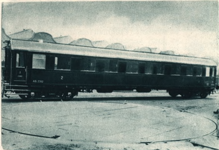
Vasvázás négytengelyű I-II. oszt. kocsí. (1927.) Uj kocsik nemzetközi gyorsvonatok részére. — Wagen I-II. Klasse mit Eisengerippe und 4 Achsen. (1927.) Neue Wagen zu internationalen Eilzügen. — Wagon de I-IIe classe, à quatre essieux, armature de fer. (1927.) Voitures neuves pour trains internationaux — I-II. Class-waggon with iron-frame and four axles. (1927.) New waggons for international express trains.
