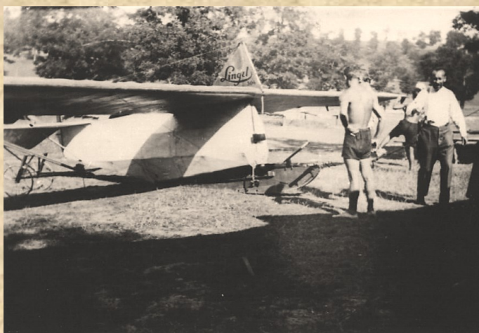
Lingel gyártású gép, burkolt törzssel. Zingó 251 nevet kapott az ilyen megoldású gép
