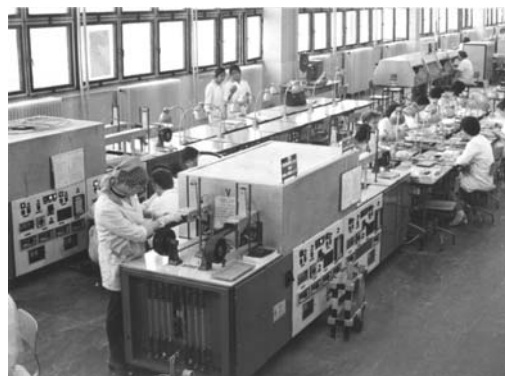
Folyamatosan működő ötvözökályha ötvözött Ge-tranzisztorok gyártásához a Gyöngyösi Félvezető- és Gépgyárban.
