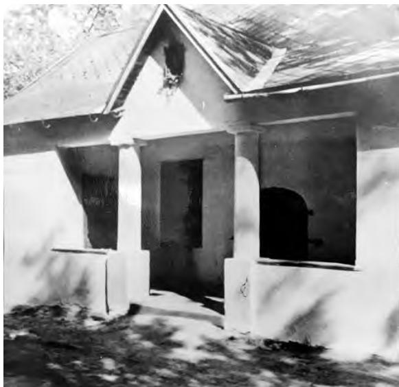
A borház bejárata
