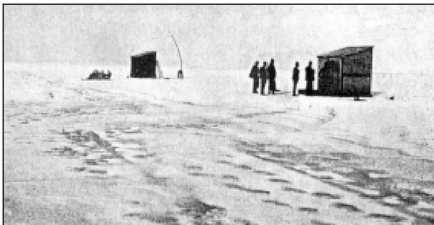
„Mérő-állomás a Balaton jegén. A báró Eötvös Lóránd-féle csavaros mérleggel mértük a föld belsejében a sűrűbb és kevésbé sűrű tömegek elhelyezkedését. Balra a lakósátor; jobbra a műszersátor.” Cholnoky Jenő fényképe.
